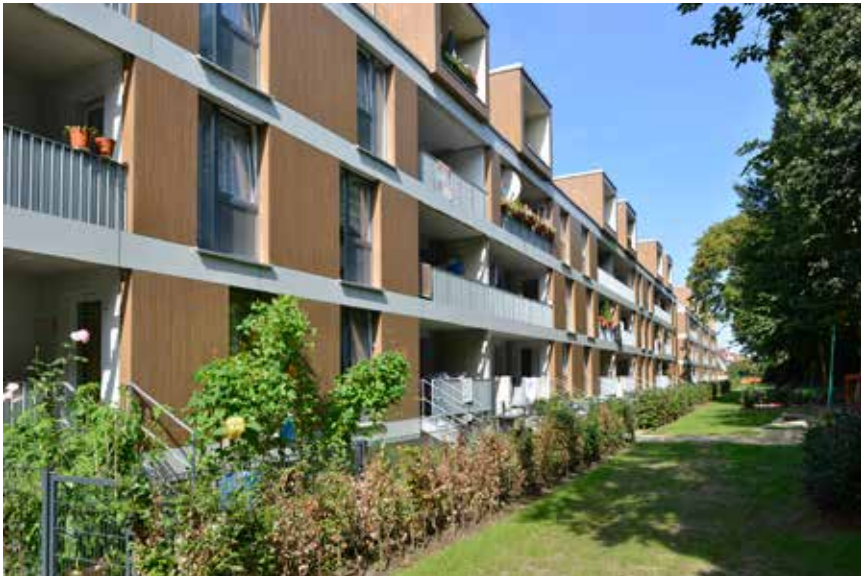
Figur 5: Exempel på omvandling i Weltquartier: genom att bygga ut mot gården skapas större lägenheter samtidigt som byggnaderna kan göras mer energieffektiva. Foto: IBA Hamburg GmbH / Martin Kunze.
