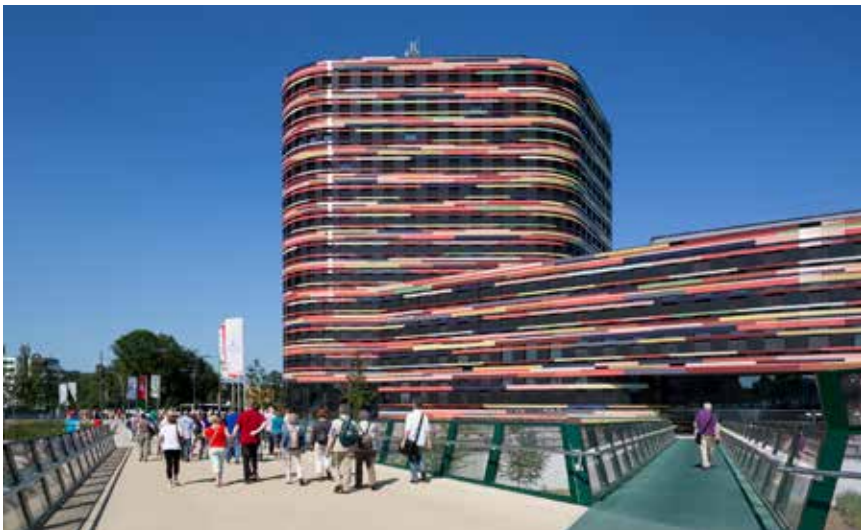
Figur 9: Delstatsministeriet för stadsutveckling och miljöns nya kontorsbyggnad i Wilhelmsburg Mitte. Arkitekt:SauerbruchHutton. Foto: IBA Hamburg GmbH / Bernadette Grimmenstein.
