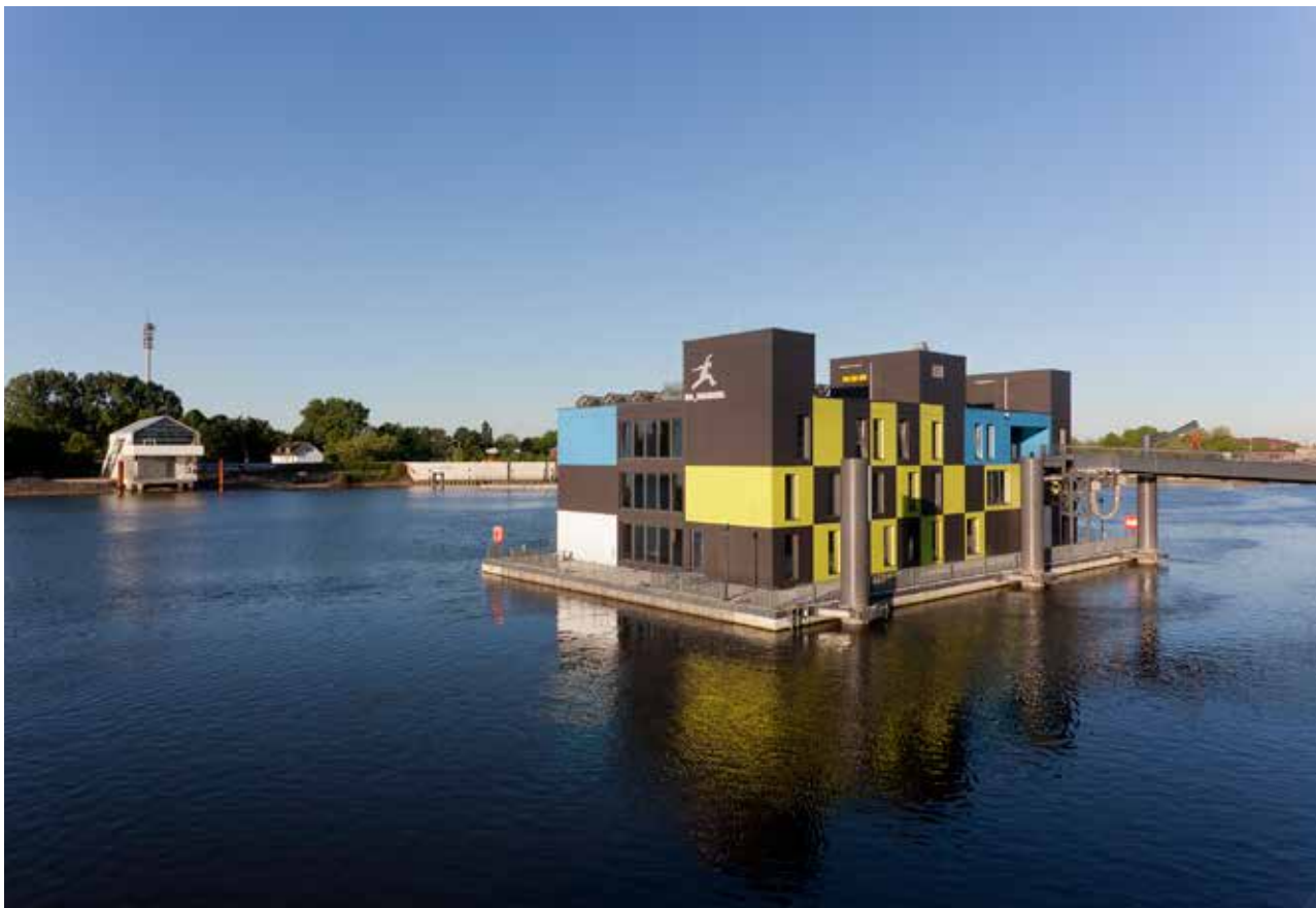
Figur 7: Den flytande kontors- och utställningsbyggnaden IBA DOCK. Arkitekt: Han Slawik. Foto: IBA Hamburg GmbH / Bernadette Grimmstein.
