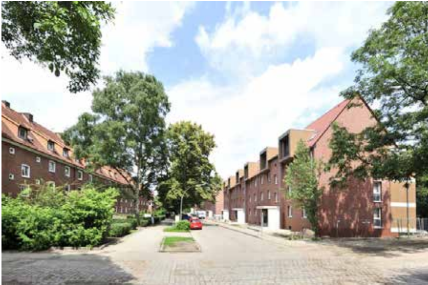
Figur 4: Exempel på omvandling i Weltquartier: framsidorna fick nya entréer, tilläggsisolerades och kläddes med tegel som kopplar tillbaka till områdets historiska rötter. Foto: IBA Hamburg GmbH / Martin Kunze.
