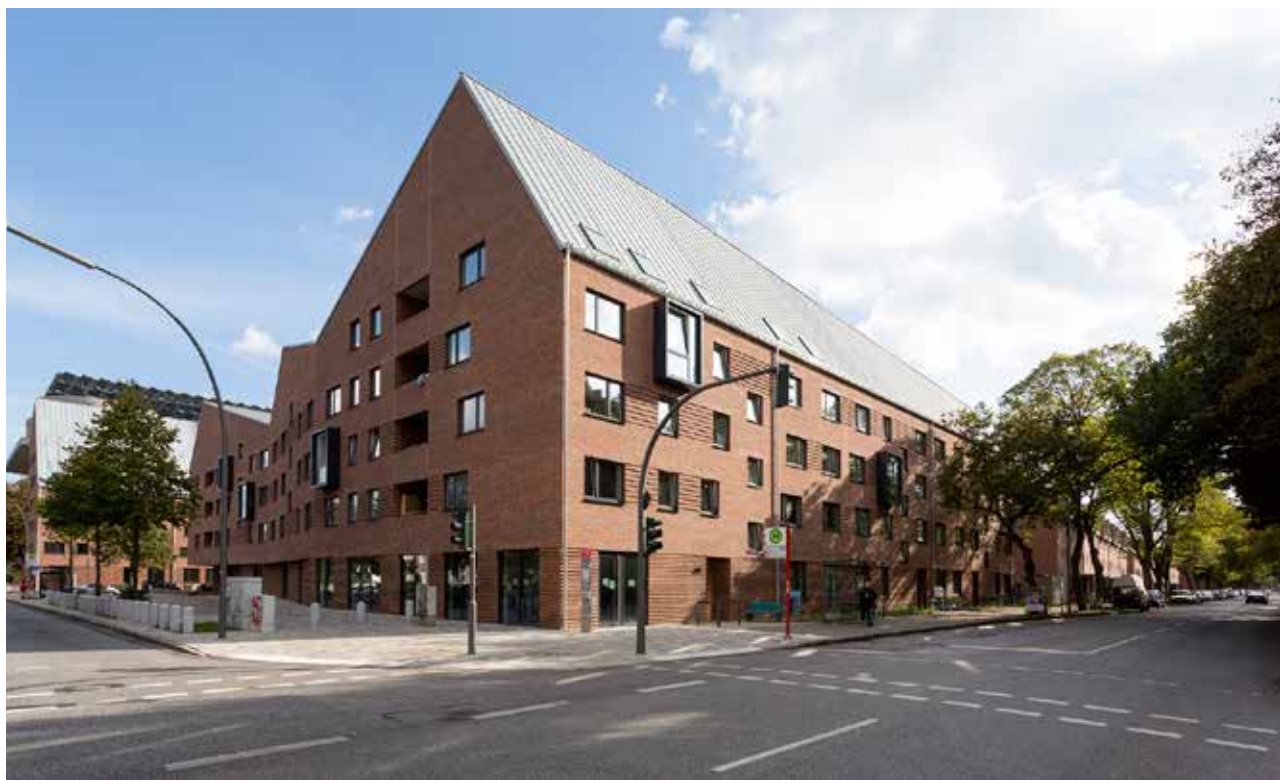
Figur 6: De nya bostadshusen bidrar med större lägenheter i Weltquartier. Arkitekt: Gerber Architekten. Arkitekt: Han Slawik. Foto: IBA Hamburg GmbH / Bernadette Grimmenstein.
