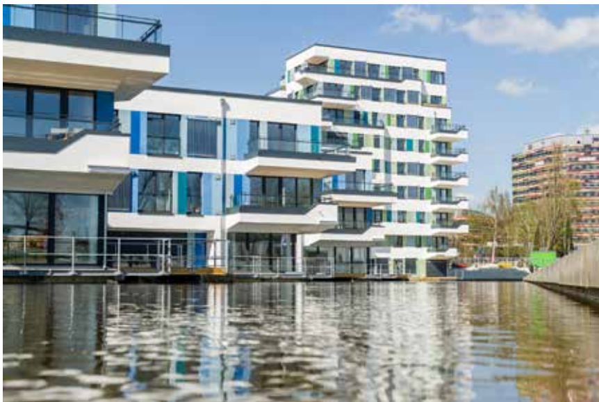
Figur 11: Smart Material Houses: BIQ-huset med "bioreaktorfasad". Arkitekt: Splitterwerk och Arup. Foto: IBA Hamburg GmbH / Bernadette Grimmenstein.
