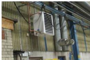
Byte från elvärmdda aerotemperar till vattenvärmda
