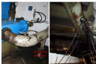
Byte av spolventil till södra rampen i BBV
