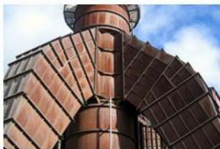
Ombyggnad av filter
