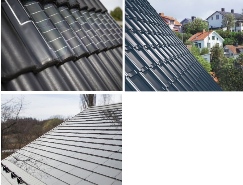
Figur 6 Solcellstakpannor installerade på tak - från vänster till höger: flexibel tunnfilm utanpå kupade takpannor (se även nästa avsnitt), kupade solcellspannor, släta solcellspannor 14
