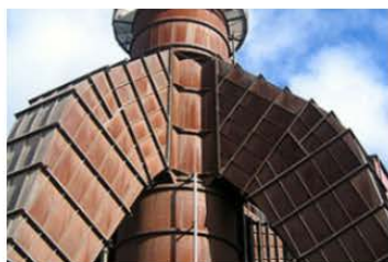
Ombyggnad av filter
