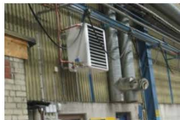
Byte från elvärmda aerotemperar till vattenvärmda
