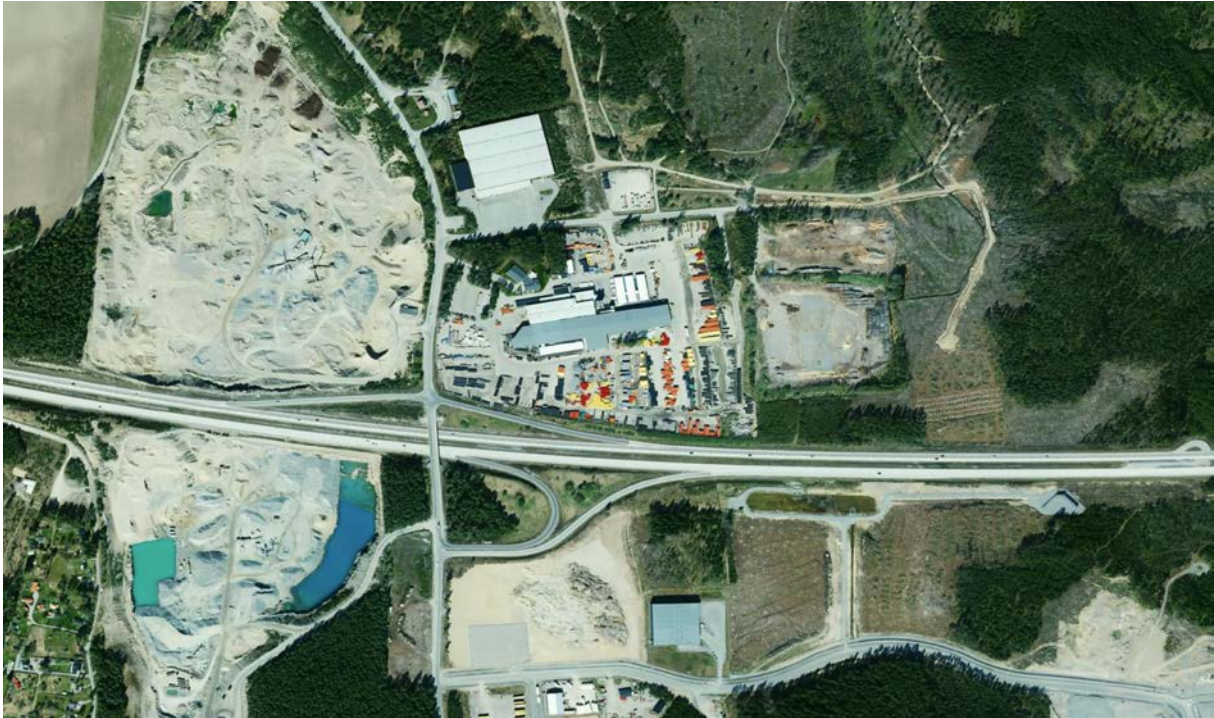
Figur 3.20: Översikt över området i Kjala där solcellsparken byggs till höger i bilden.
