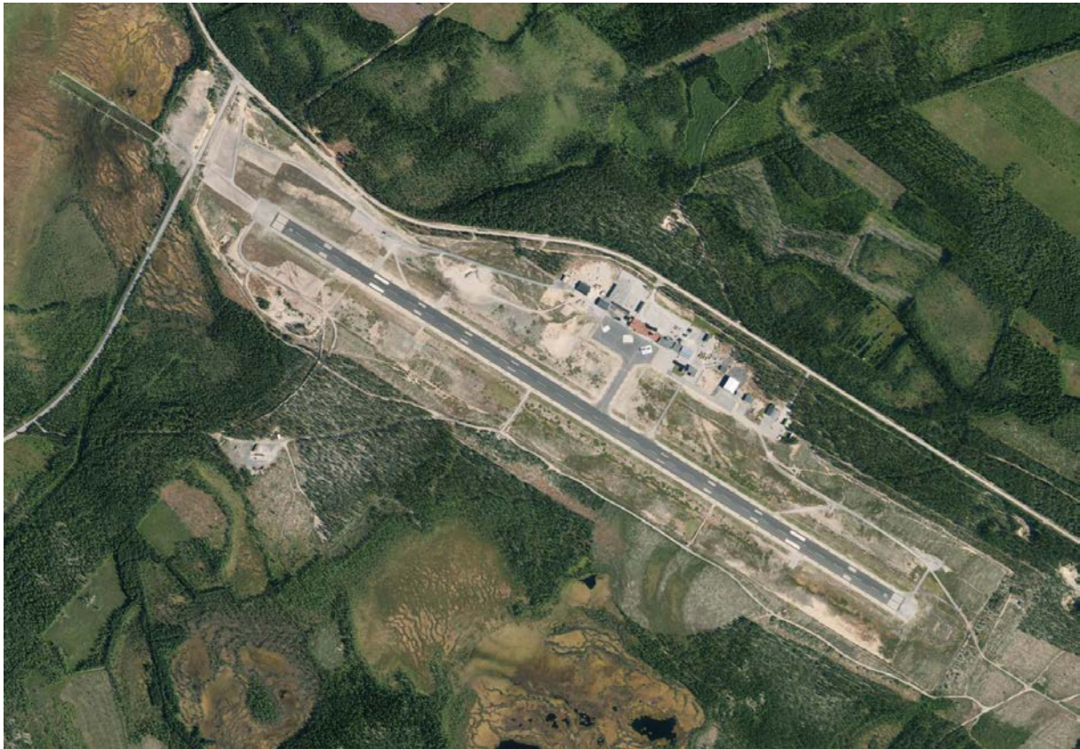
Figur 3.14: Flygfoto över Örnsköldsviks flygplats.
