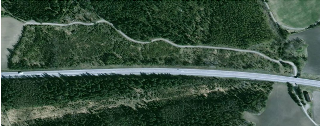
Figur 3.18: Flygfoto över solcellsparken "MegaWattparken" intill E18 öster om Västerås, innan den byggdes.
