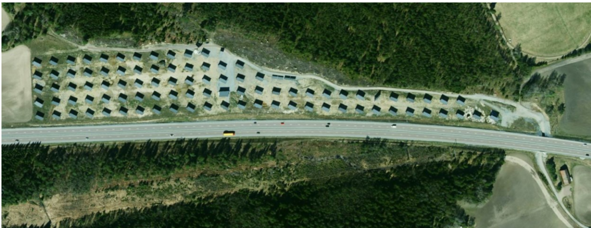
Figur 3.19 Flygfoto över solcellsparken "MegaWattparken" intill E18 öster om Västerås, efter den byggts.
