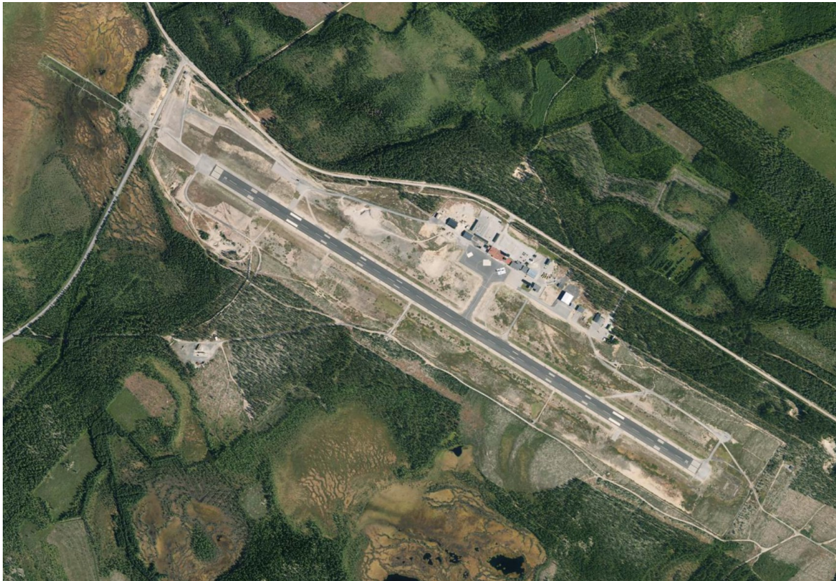
Figur 3.14: Flygfoto över Örnsköldsviks flygplats.
