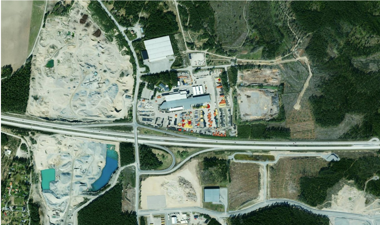
Figur 3.20: Översikt över området i Kjala där solcellsparken byggs till höger i bilden.
