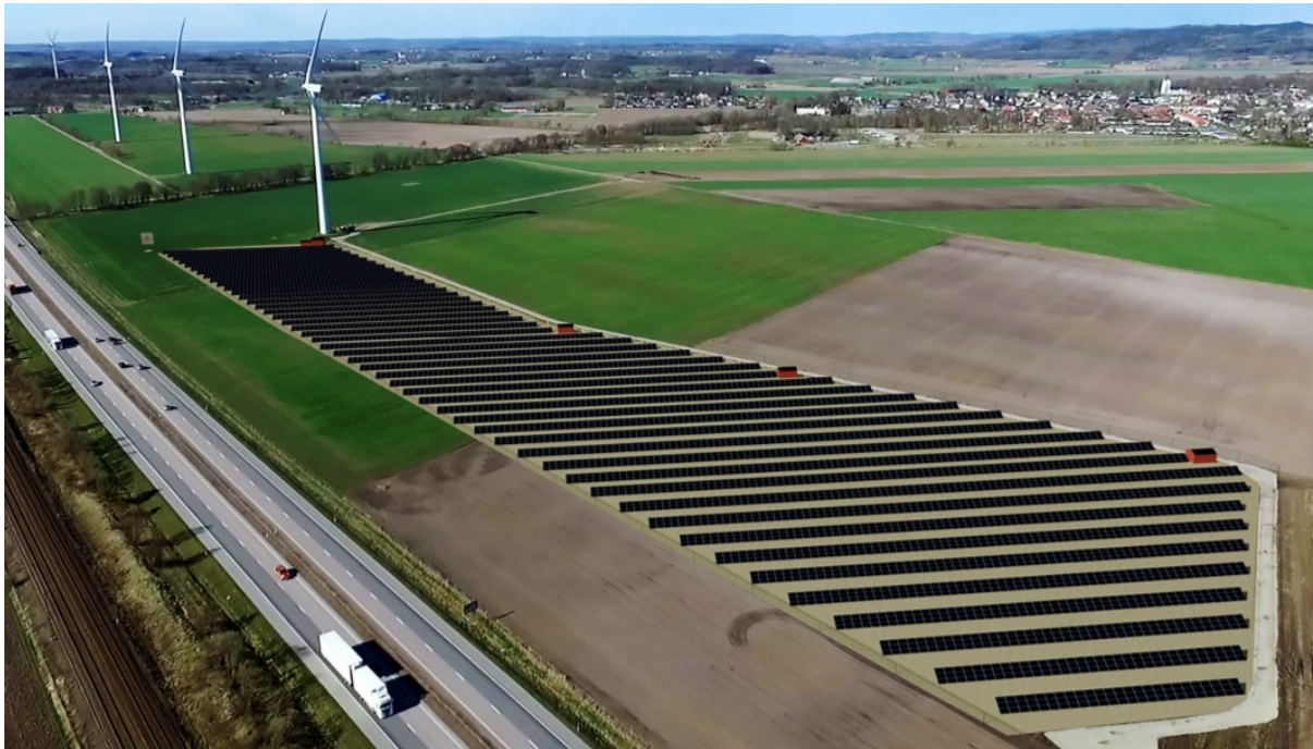
Figur 3.11: översiktsbild över Sveriges största solcellspark "Solsidan" utanför Varberg.
