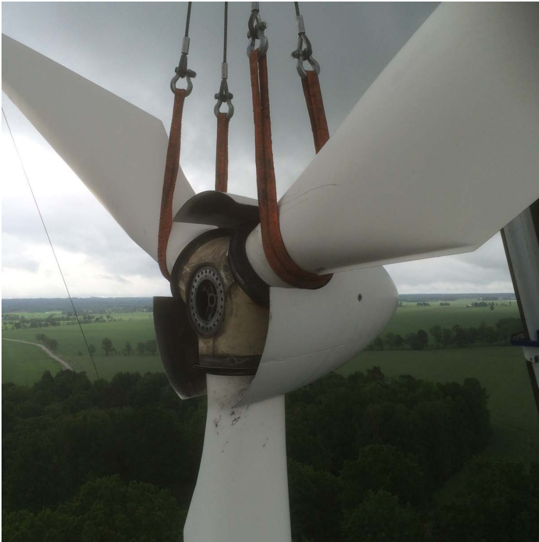
Nedmontering av vindkraftverk. Foto: Mats Flodman
