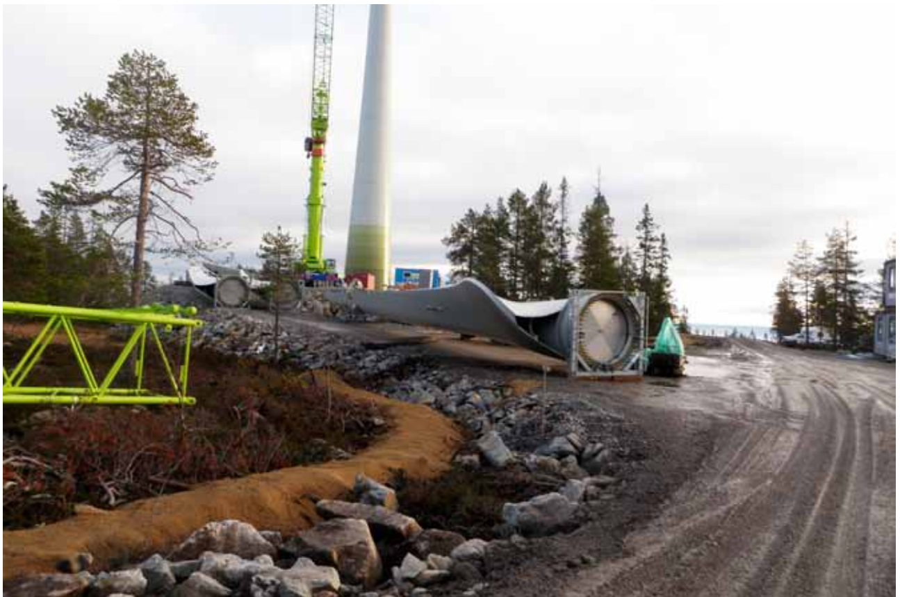
Vingarna är utrustade med ett avisningssystem (varmluft inuti vingarna) för att förhindra isbildning.
