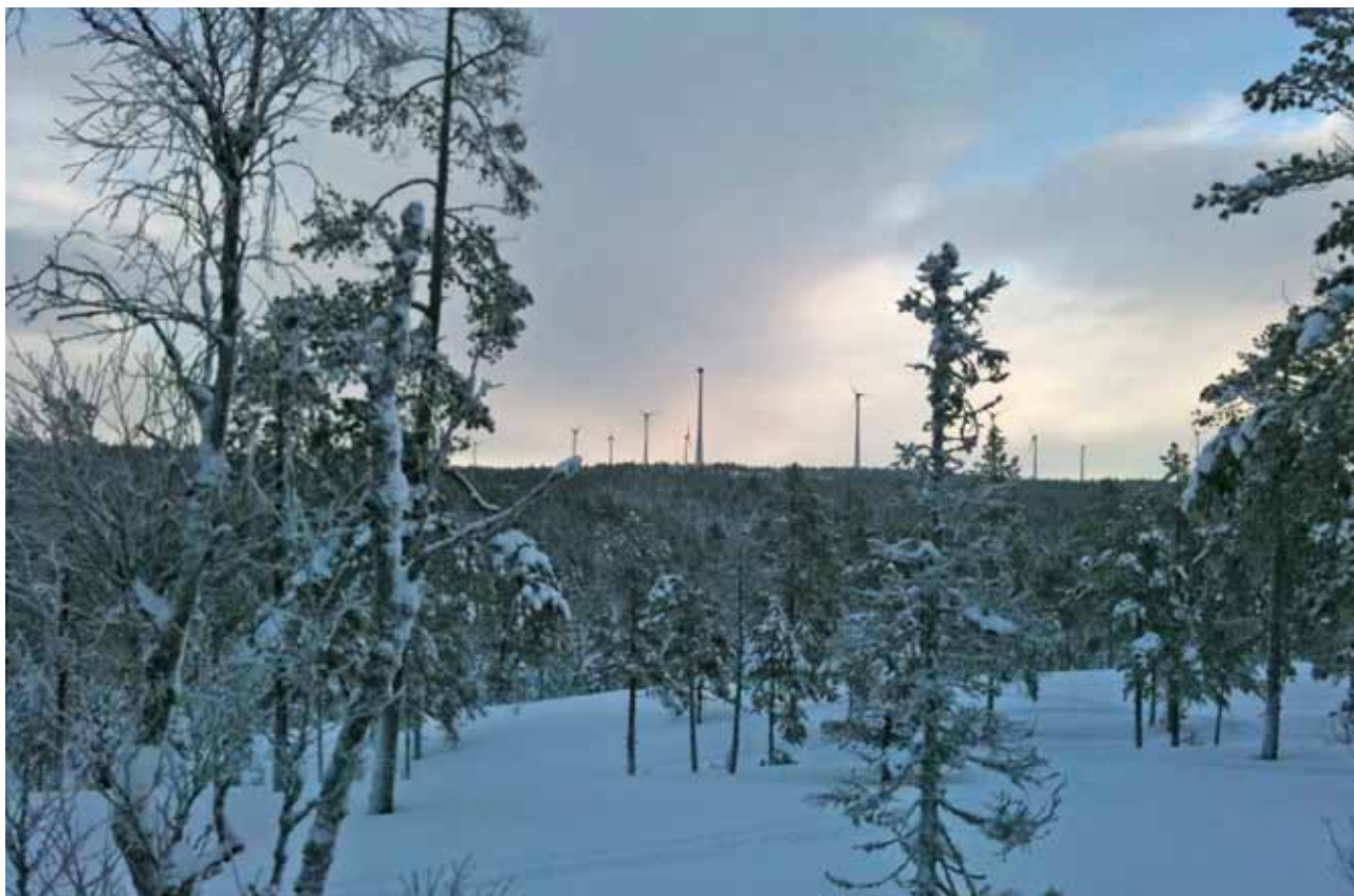
Det första vindkraftverket togs i drift i slutet av december 2010, därefter har resterande 19 vindkraftverk inom Etapp Syd tagits i drift allt eftersom. Det 20e vindkraftverket togs i drift i april 2011.
