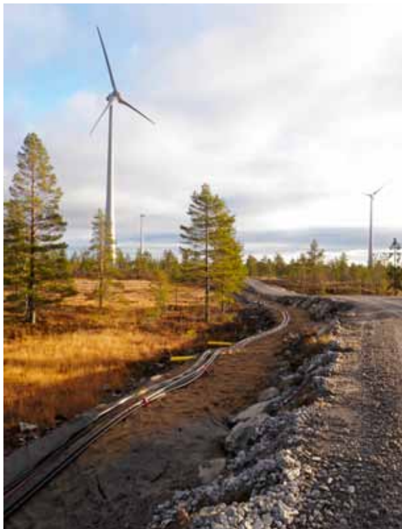
Under december 2010 då Byrkjje flyttade ner renarna till Lögdeå vinterland pågick arbete med att gräva ner kraftledningar intill vägkroppen
