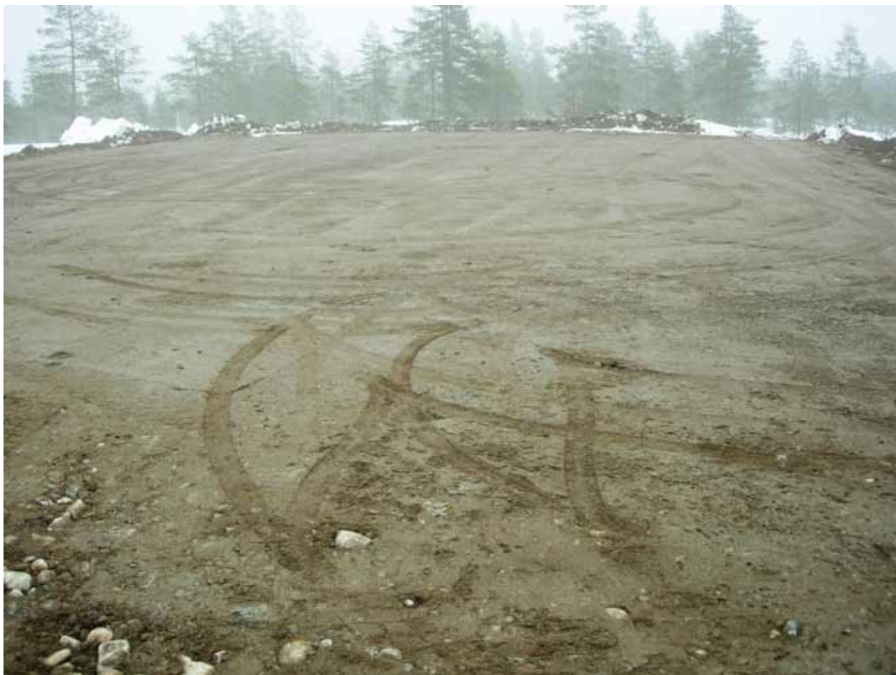
Bilden visar en kranplats. Normalt har 1200-1300 m 2 tagits i anspråk för kranplatserna
