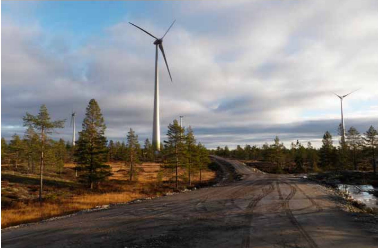
I december 2010 då Byrkjje kom ner med renarna till vinterlandet Lögdeå var tio vindkraftverk byggda och ytterligare tio vindkraftverk under slutmontering.
