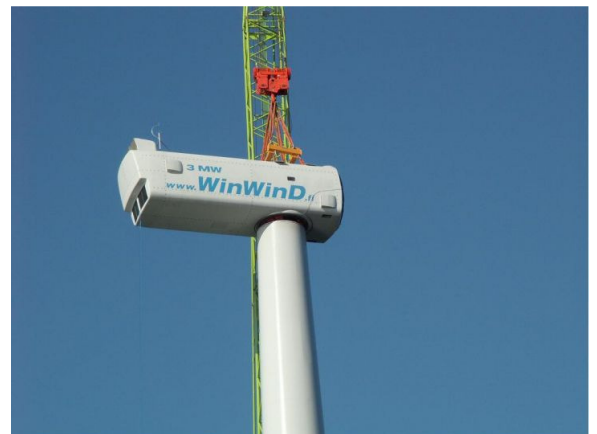
Figur 8.13 Montage av maskinhus/nacelle
