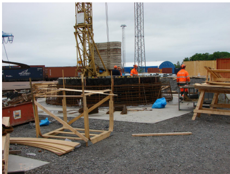
Figur 10.2 Arbete med formens insida
