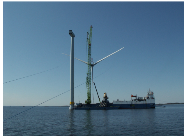
Figur 8.17 Montage av rotor
