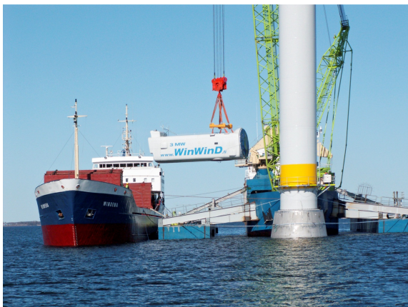
Figur 8.12 Lyft av maskinhus (M/S Windena och M/S WestWind)
