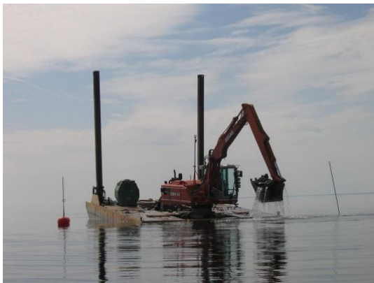
Figur 8.2 Schaktning av sjöbotten
