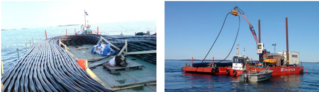
Figur 11.8 Kabelförläggning
