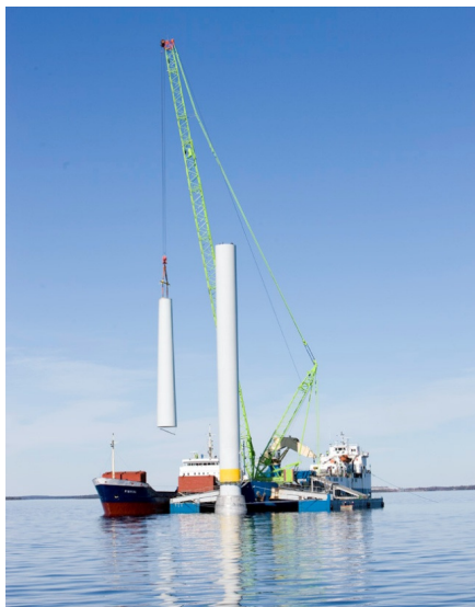
Figur 8.11 Lyft av torndel (M/S Windena och M/S WestWind)
