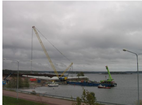
Figur 8.15 Lyft av rotor till pråmen Kanalia
