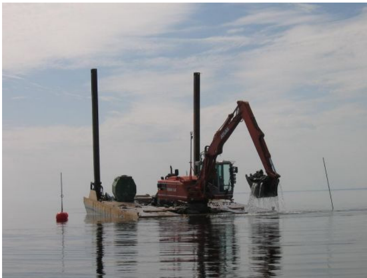
Figur 10.1 Moränschaktning
