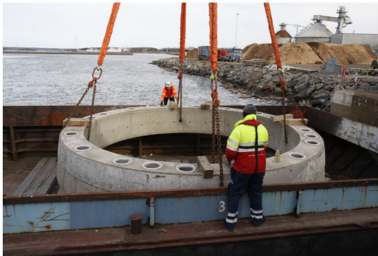
Figur 8.3 Fundament förbereds för transport till sjöss
