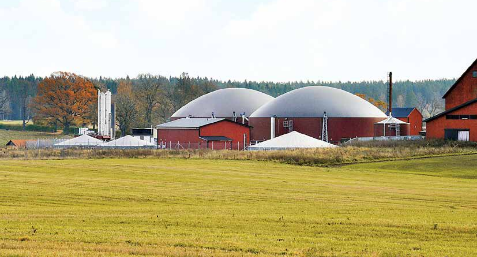
Biogasanläggning i Katrineholm.
