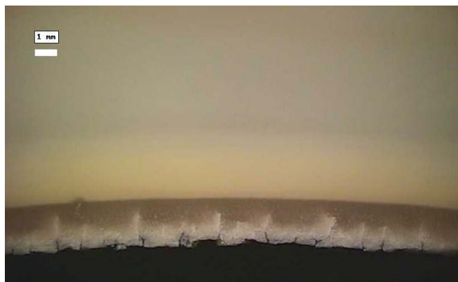
Figur 47. Korrosion i ett PP-rör som används 17 år för blandsyra (20wt% HNO 3 och 4wt% HF)
