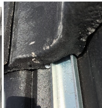
Figur 31. Underkant tegelpanna är ursågad för att ge plats åt staget.
