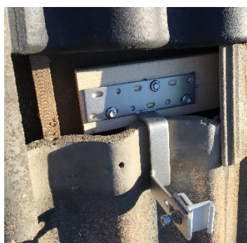
Figur 29. Stag skruvat ner i råsponten.
