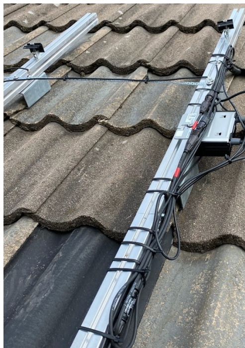
Figur 16. Förberedelse av återföringskabel och optimerare innan montage av moduler.
