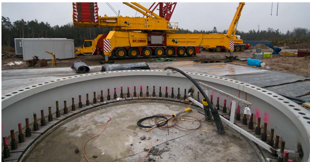
Bild 24: Stag apterade och förspända.
