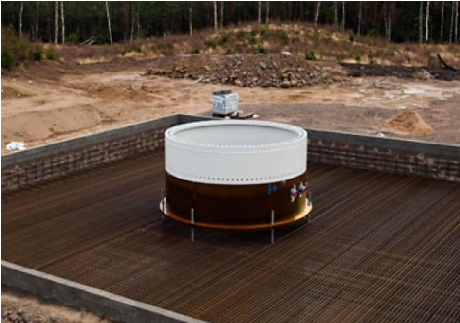
Bild 8: Insert ring monterad
