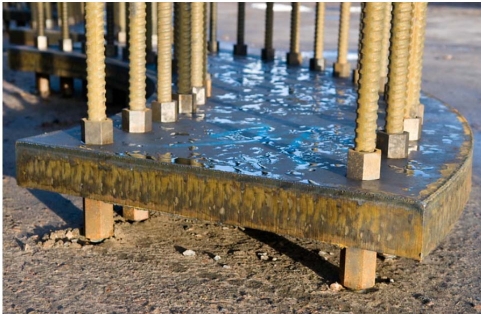
Bild 15: Bottenförankring (stålplatta) av spännstag
