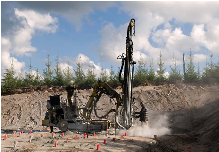
Bild 1: Förberedelse för bortsprängning av berg
