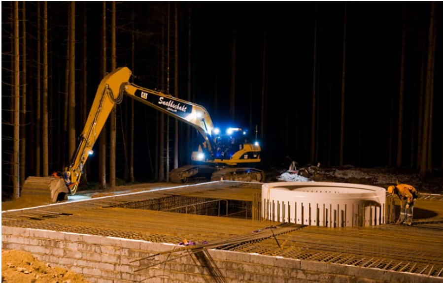
Bild 19: Överkantsarmering och skjuvarmering monteras
