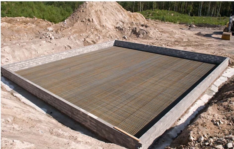
Bild 5: Underkantsarmering på plats
