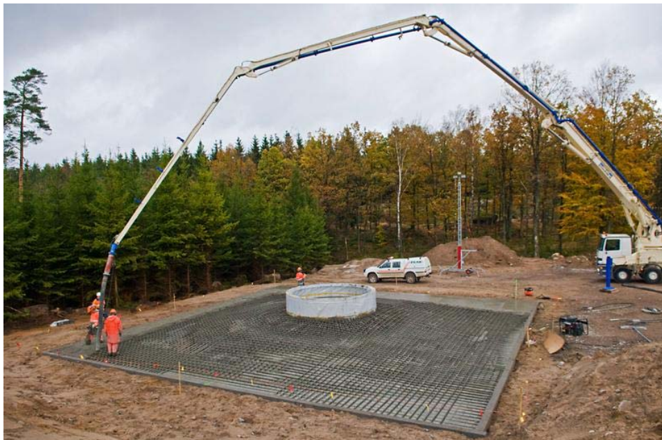
Bild 13: Gjutning fundament av ursprungsdesign.
