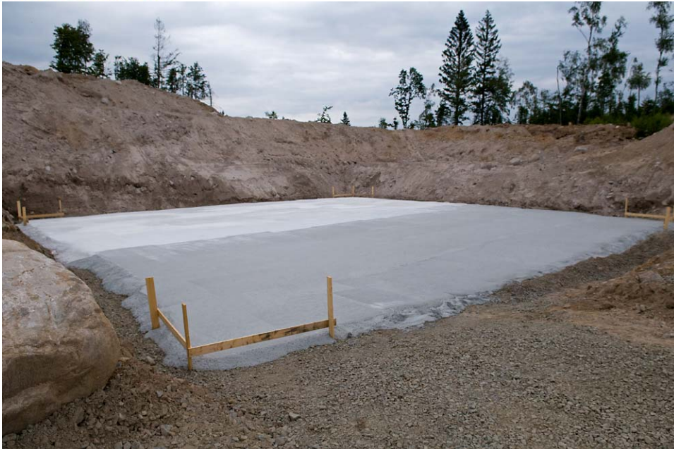
Bild 2: Färdig grovbetong
