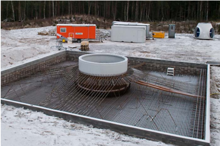
Bild 10: Överkantsarmering växer fram
