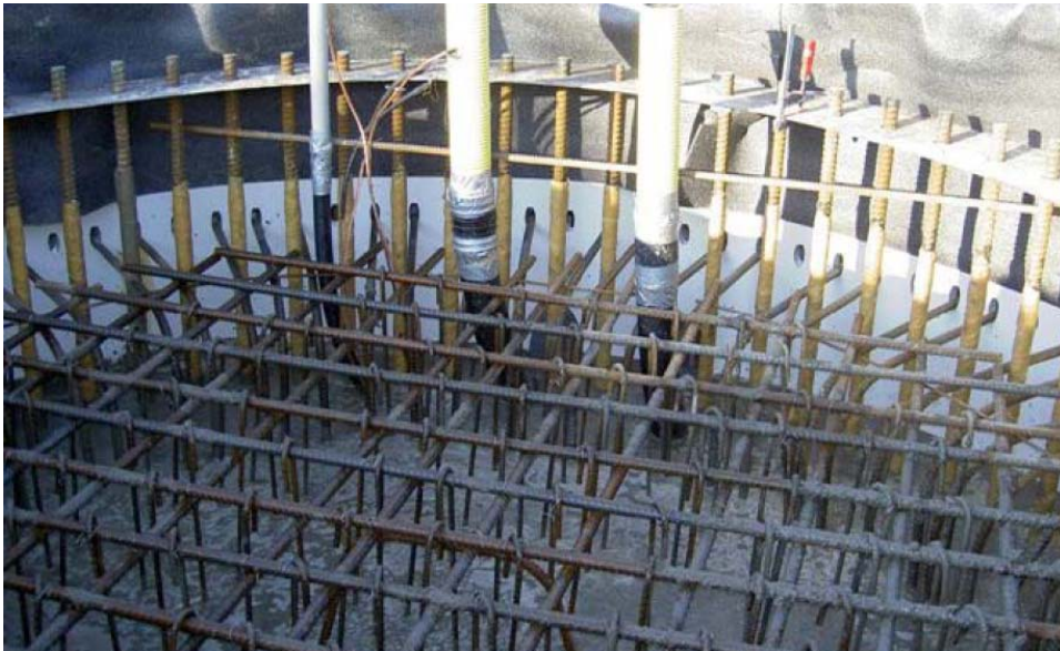
Bild 21: Överkantsarmering och skjuvarmering inom Insert ringen (jämför bild 12)
