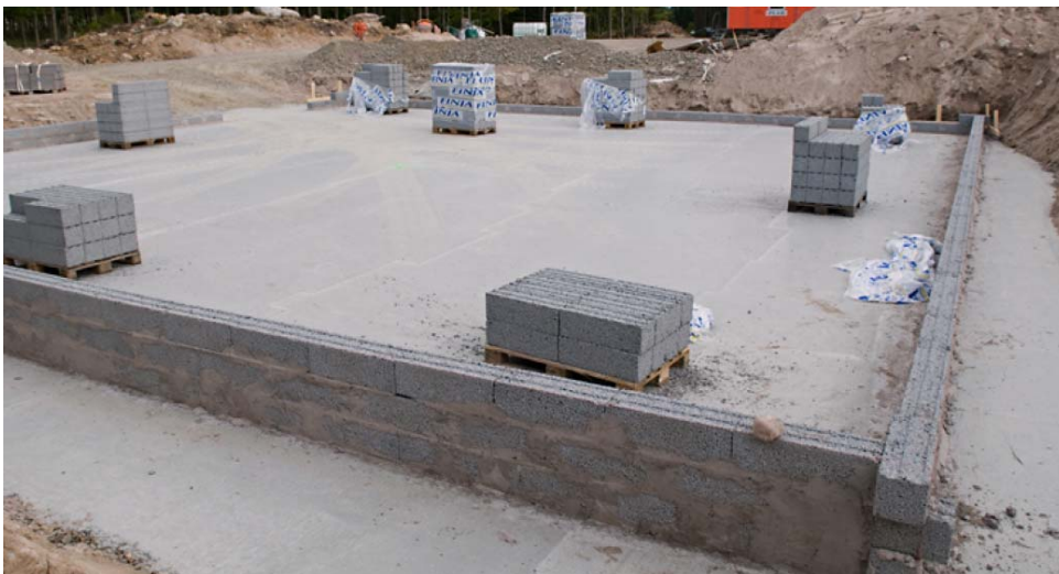
Bild 3: Uppbyggnad av form med Leka sten
