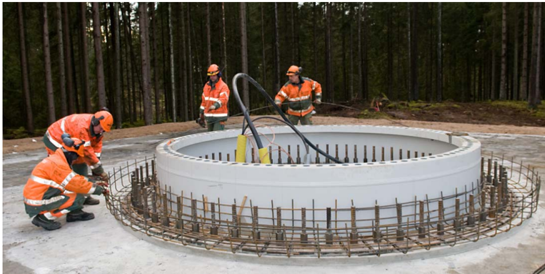
Bild 25: Formning av skyddsgjutning över yttre spännstag
