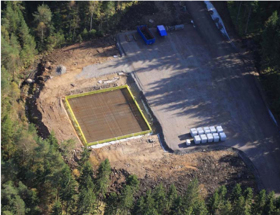
Bild 6: Prefab form sedd från ovan.
