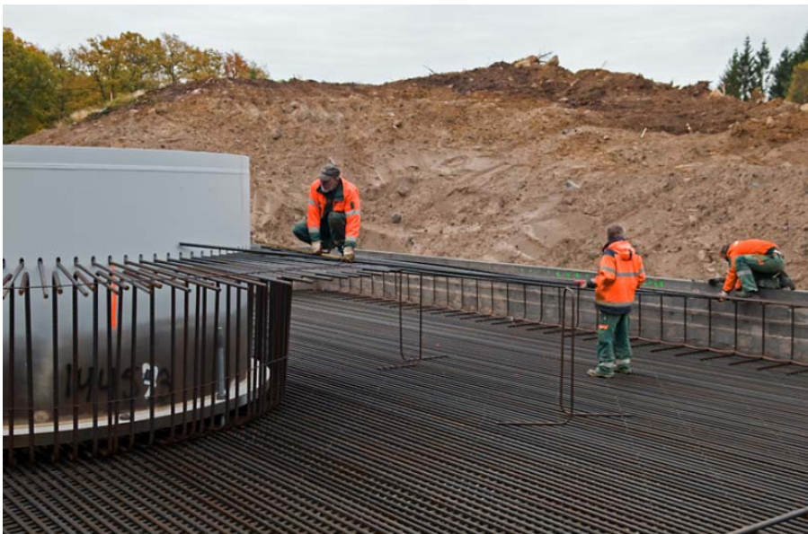
Bild 9: Armering för förankring av insert ringen i betongfundamentet monteras
