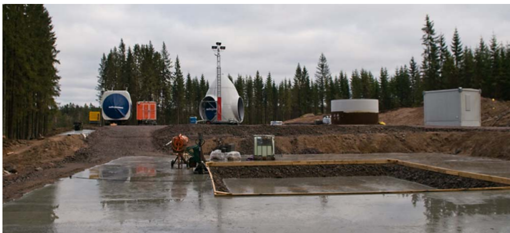
Bild 14: Grop för ingjutning av stålplatta (se bild 15) är förberedd
