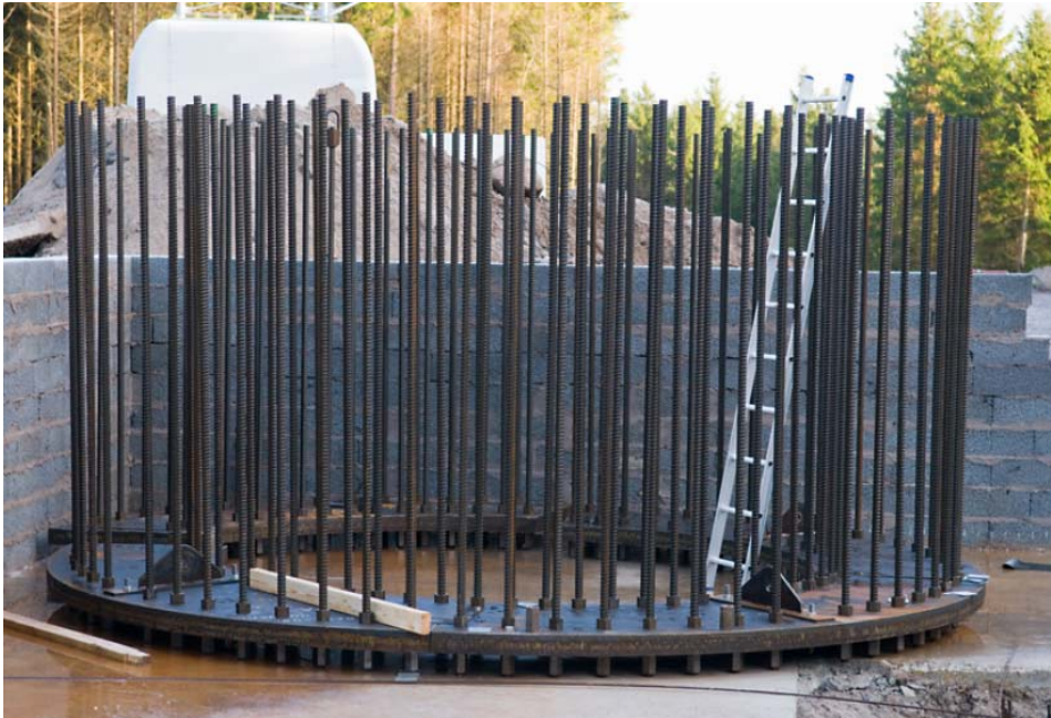
Bild 17: Och bultades ihop på plats till en enhet och varje stag lindas med Densotejp innan gjutning
