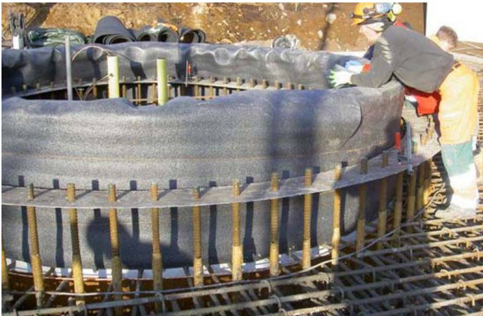
Bild 22: Spännstag och montagemall på utsida Insert ring före gjutning
