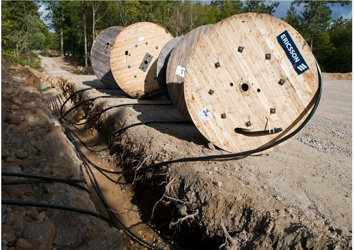
Bild 2: Kabelförläggning i Oxhult parken
