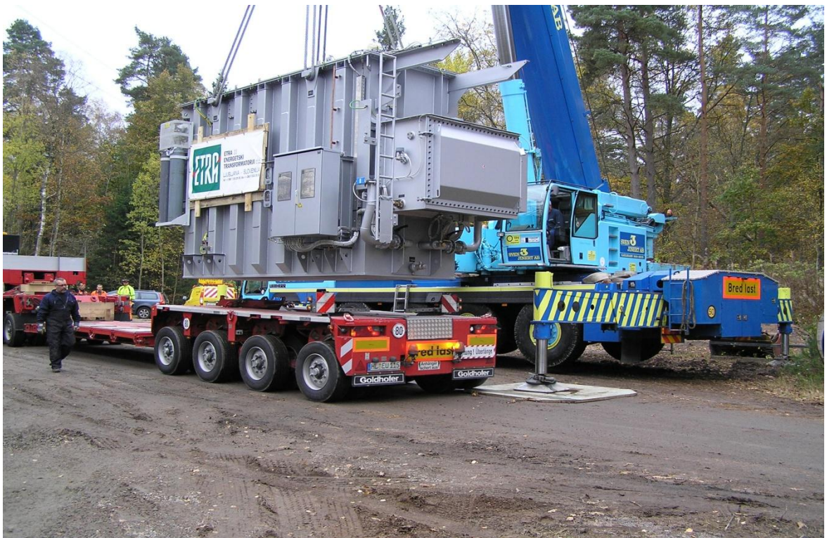
Bild 3: Omlastning av transformator
