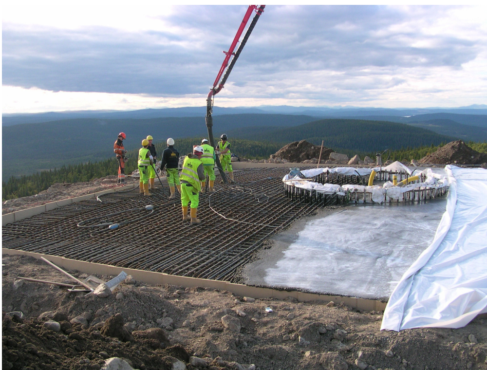
Gjutning av fundament
