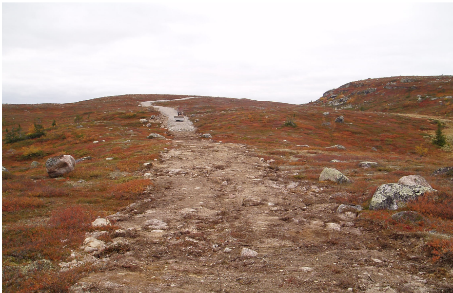
Vägar på Uljabuoudafjället under byggnation
