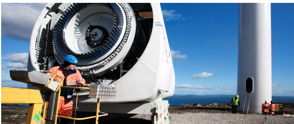
Nav och torn till ett av vindkraftverken på Uljabuouda
