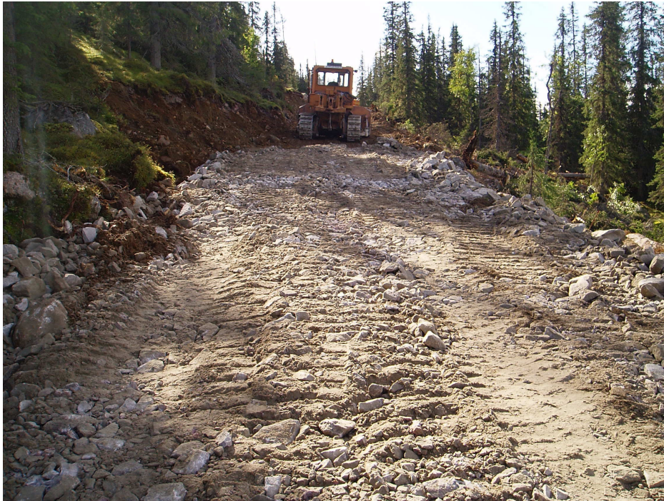
Vägen upp på Uljabuouda anläggs
