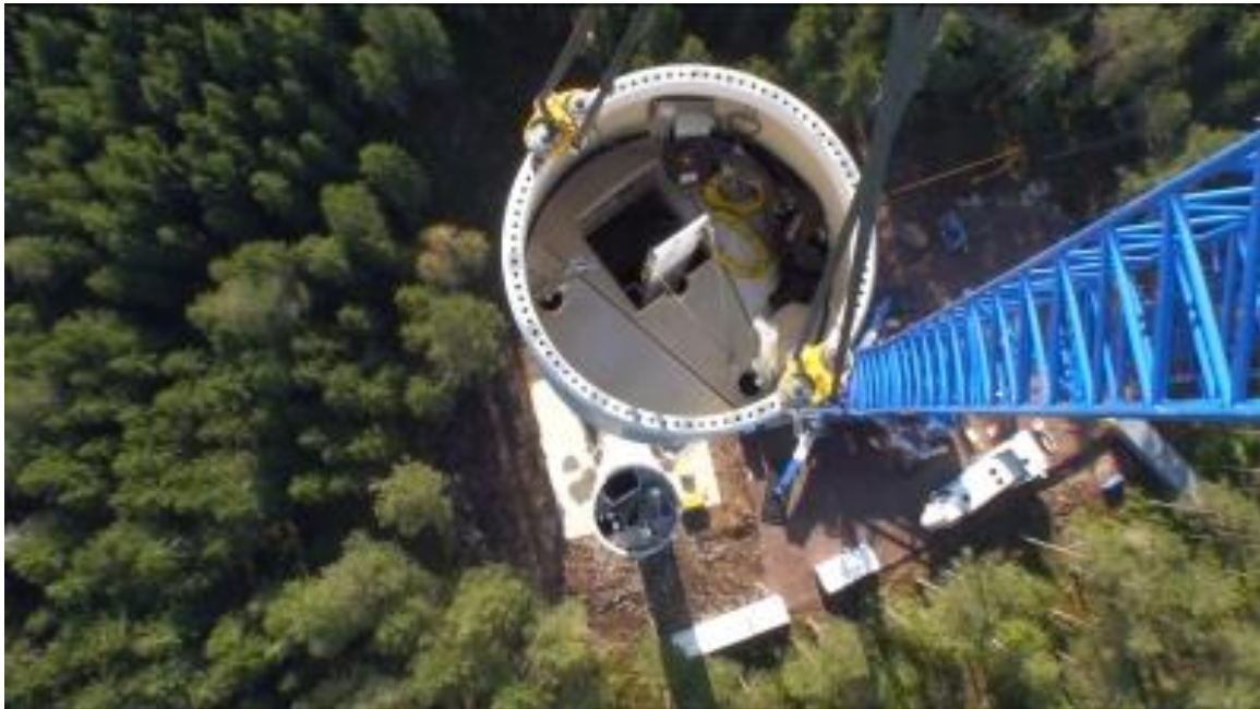
Figur 4: Montage av torndel till en Vestas V90 i Idhult.
