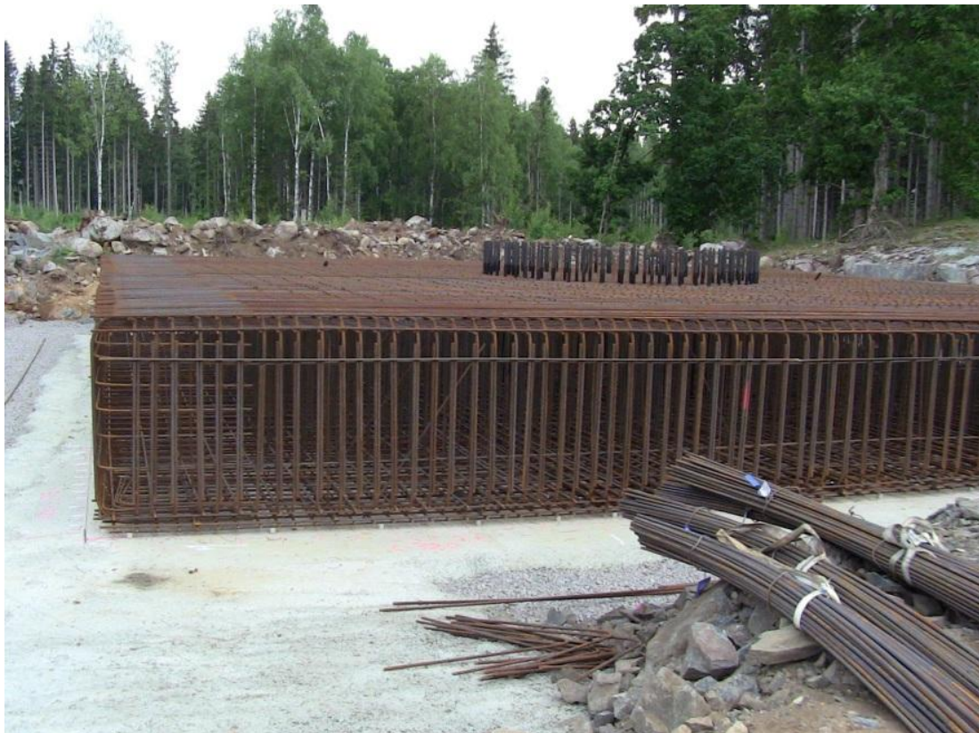
Figur 8: Armeringen av ett kvadratisk fundament utan gjutform.
