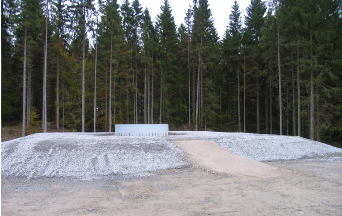
Figur 10: Färdigt fundament med adapter för V90.
