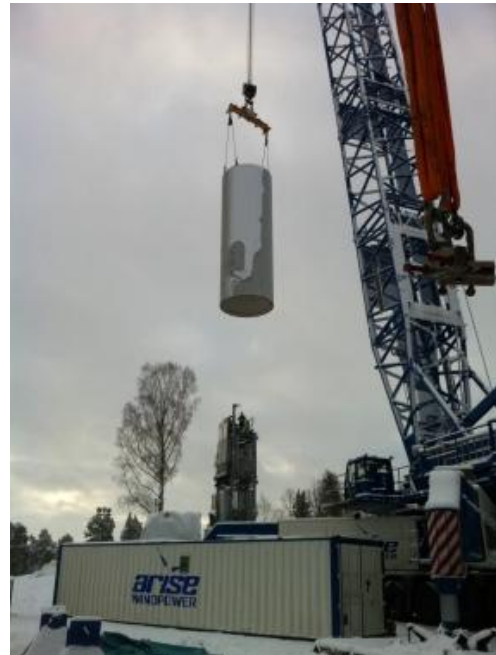
Figur 2: Lyft av torndel med Arise kran under vintertid.
