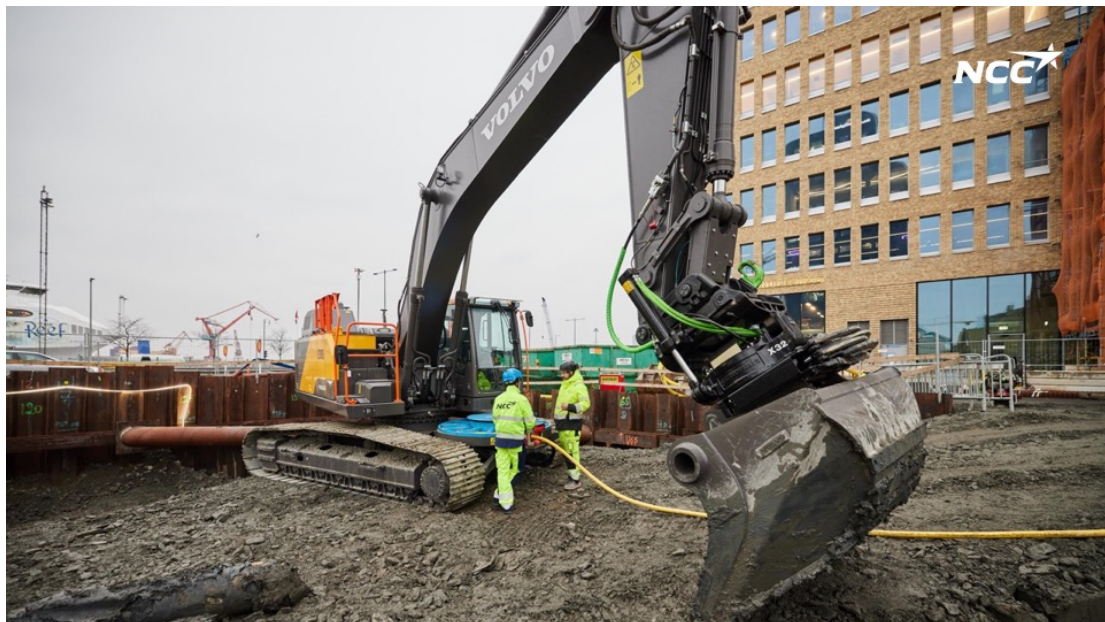
Bild 2 – 30-tons kabelansluten bandgrävare på Habitat 7
