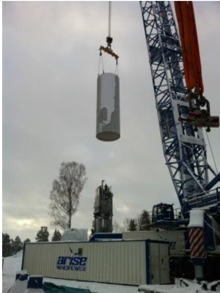
Figur 1: Lyft av torndel med Arise Kran under vintertid.
