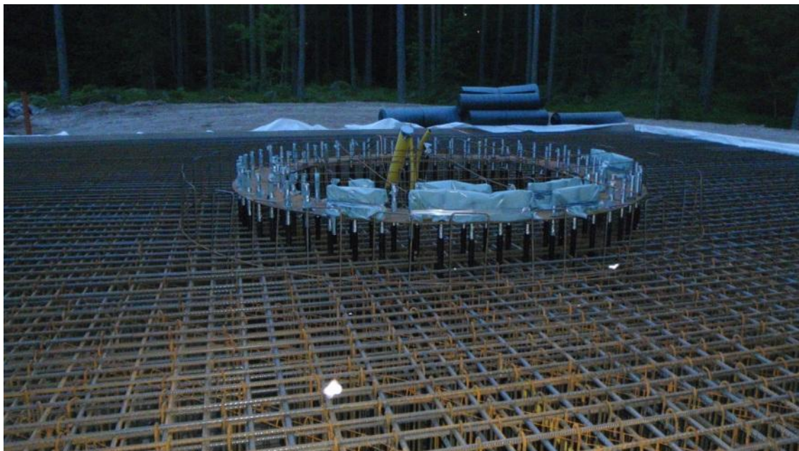
Figur 9: Flänsinfästningen av den nya designen med genomgående dragstag.
