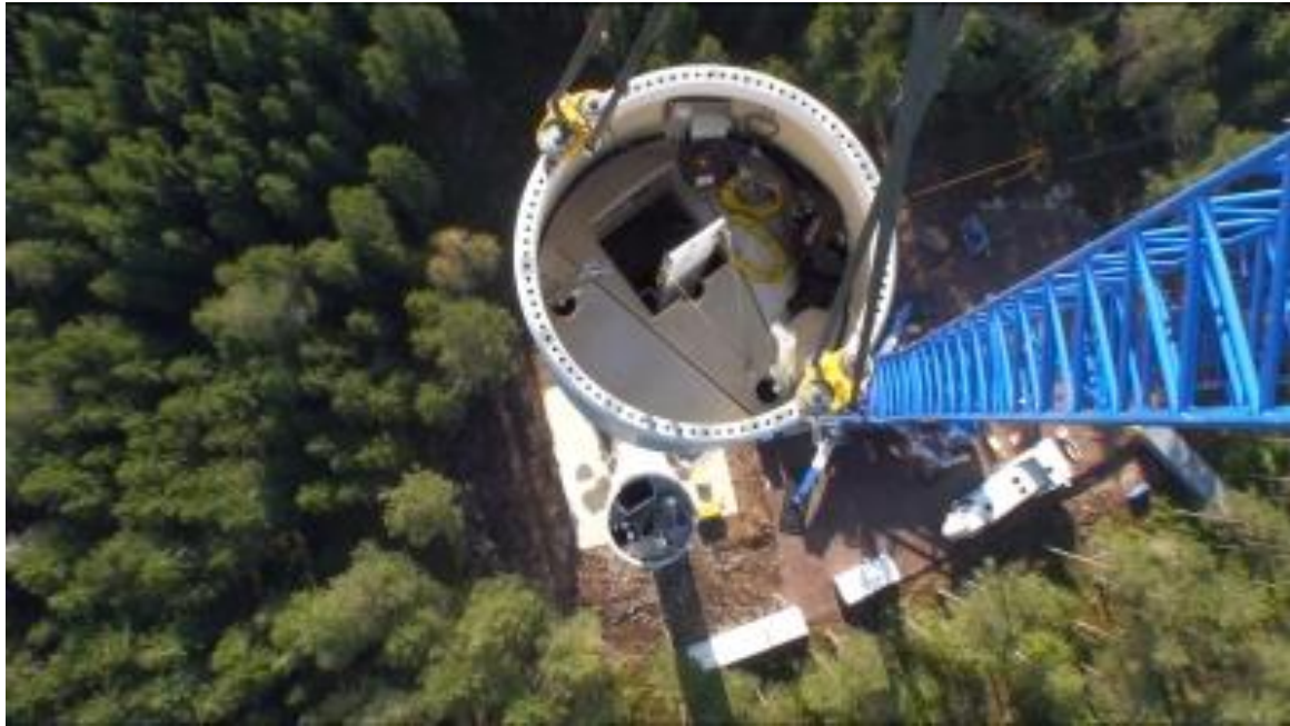
Figur 3: Montage av torndel till en Vestas V90 i Idhult.
