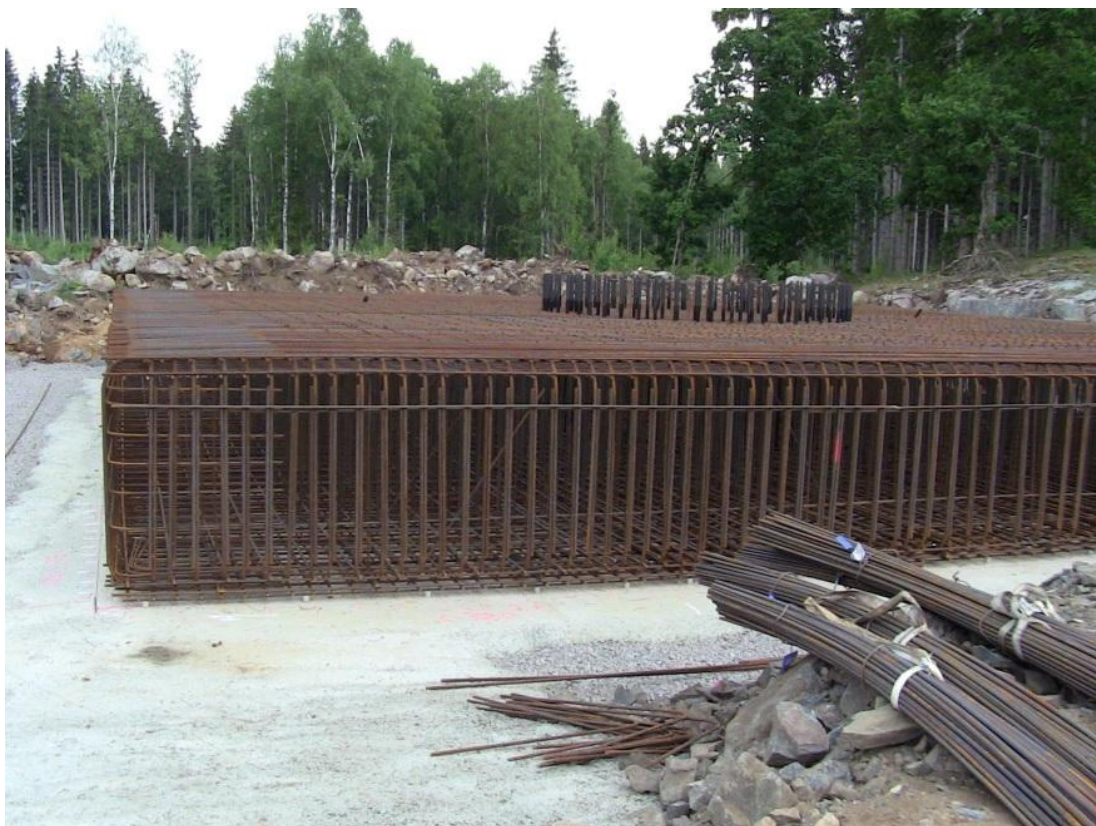
Figur 8: Armeringen av ett kvadratisk fundament utan gjutform.
