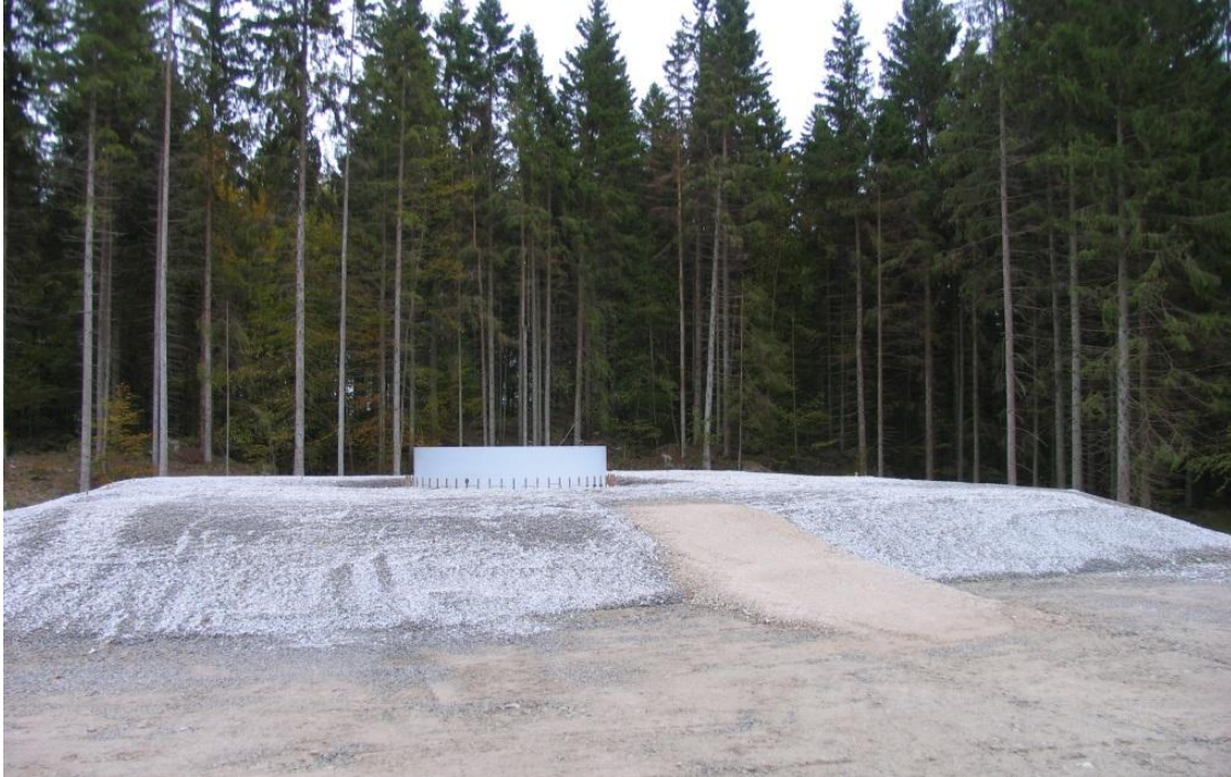
Figur 10: Färdigt fundament med adapter för V90.
