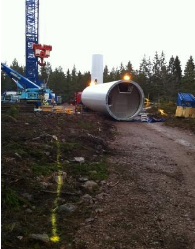
Figur 7: Markering av utökad hård yta för transport
