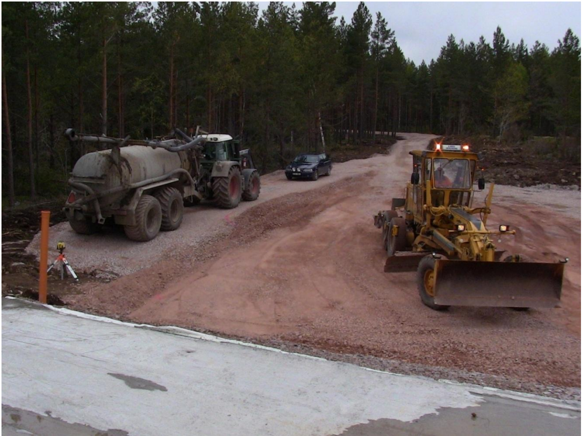
Figur 6: Byggnation av kranplantsyta där justering för tunga transporter ännu inte genomförts.
