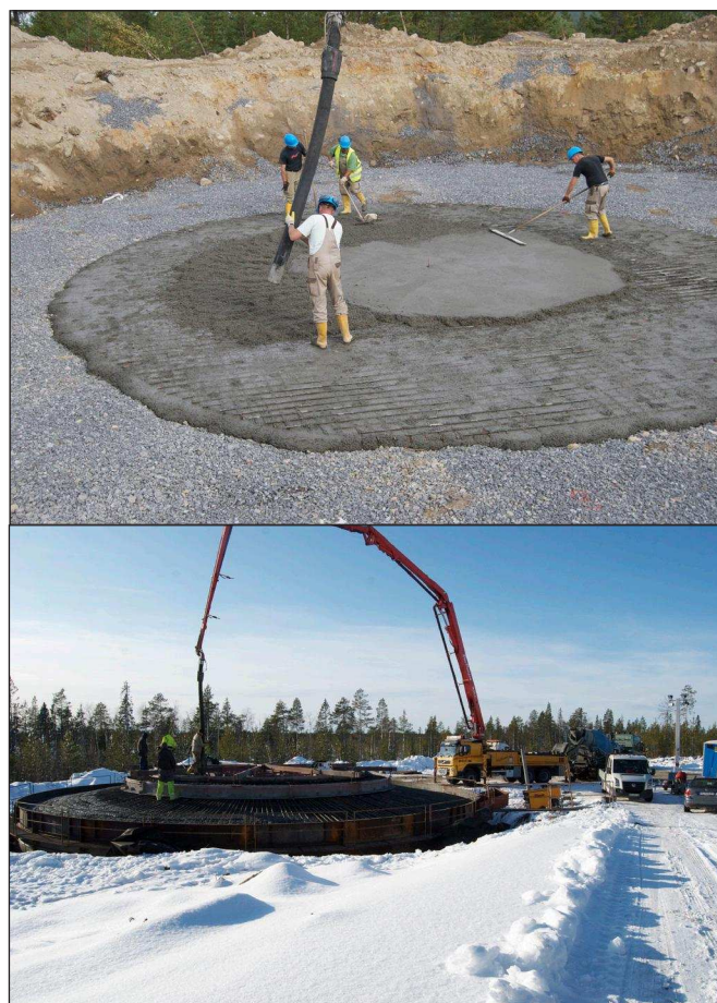
Arbete med fundament för Dragalidenprojektet. Foto: Svevind.
