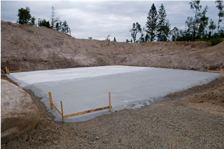
Bild 7: Undergjutning fundament
