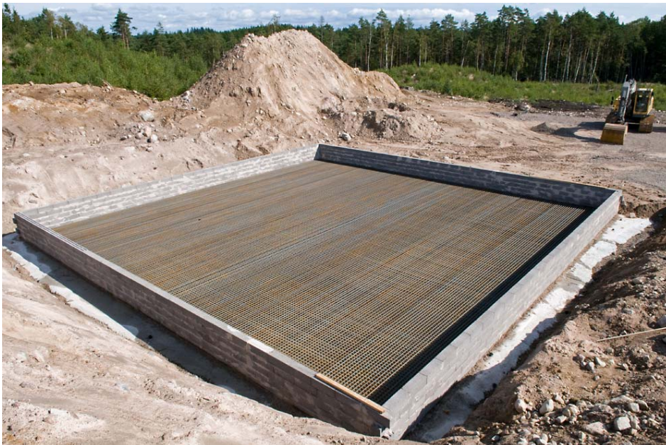
Bild 8: Formning & armering för fundament
