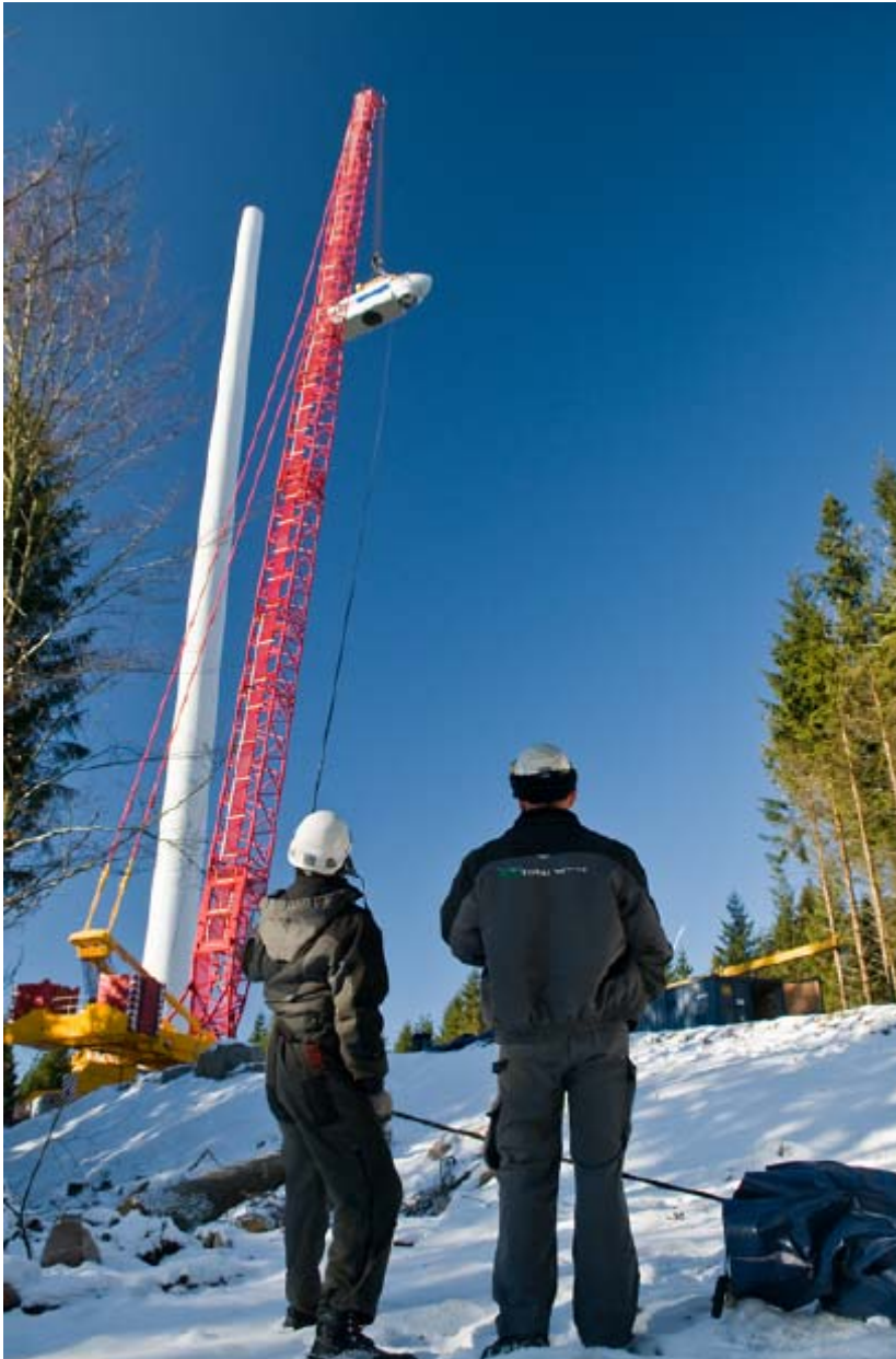
Bild 22: Nacellen lyfts på plats
