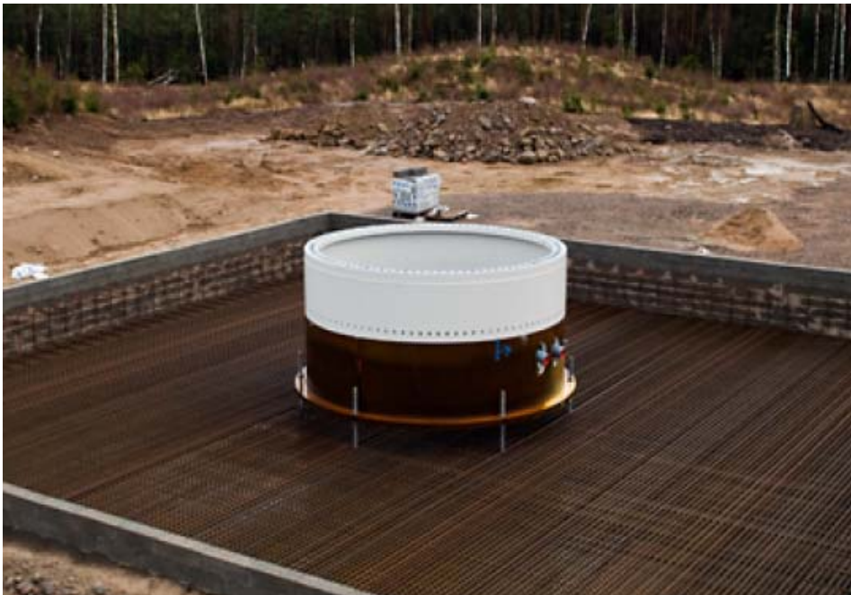
Bild 10: Gjutning fundament av ursprungsdesign. Notera insert ringen i mitten av fundamentet på vilket vindkraftverket skall monteras.
