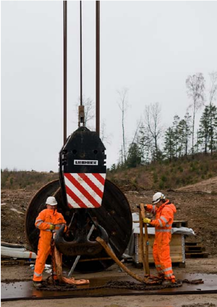
Bild 14: Lyftkroken förbereds
