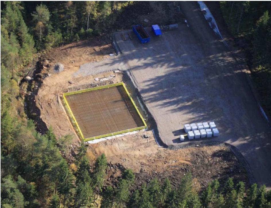
Bild 4: Fundament & kranplats från ovan.
