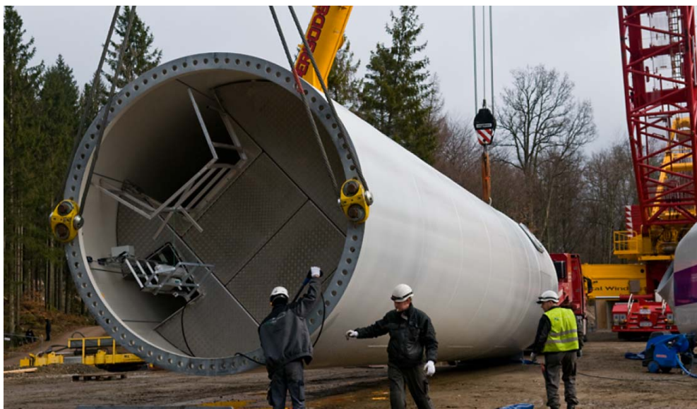
Bild 16: Lyft bottendel påbörjas
