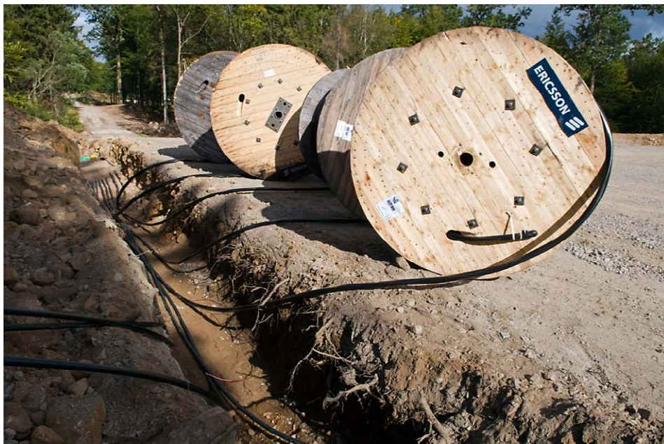
Bild 6: Kabelförläggning 36 kV * 4 kablar
