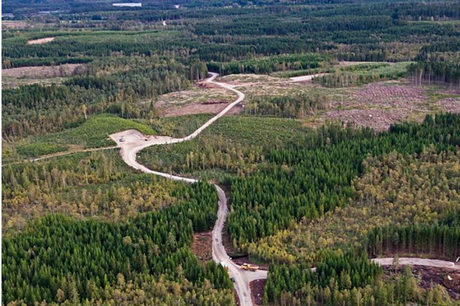
Bild 3: Ny väg & kranplats från ovan.
