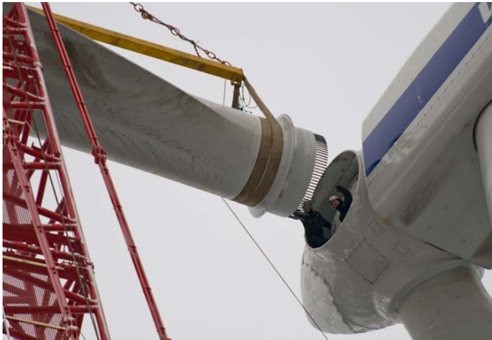
Bild 25: Vingarna fästs i navet
