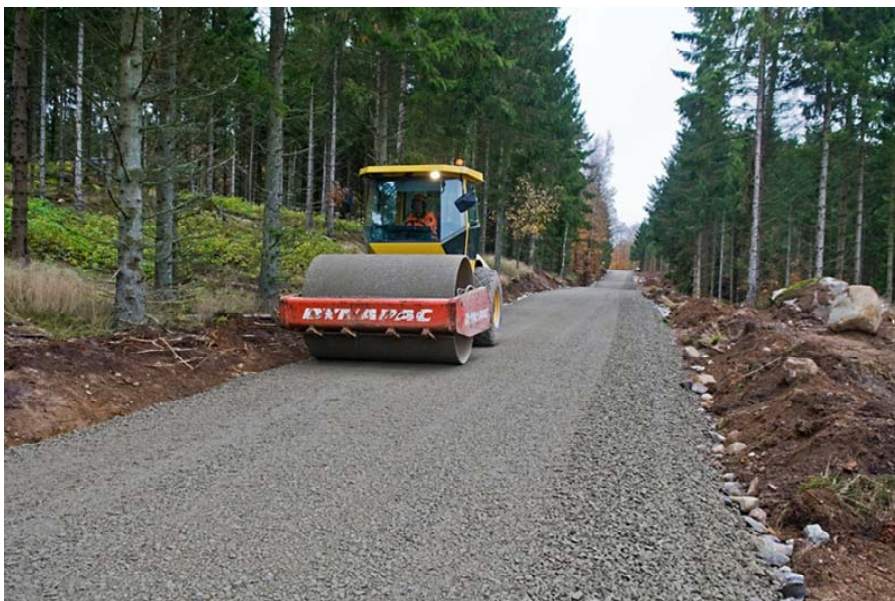
Bild 1: Breddning & förstärkning befintlig väg.
