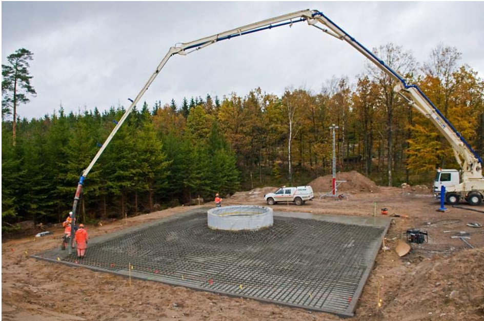
Bild 11: Gjutning fundament av ursprungsdesign.
