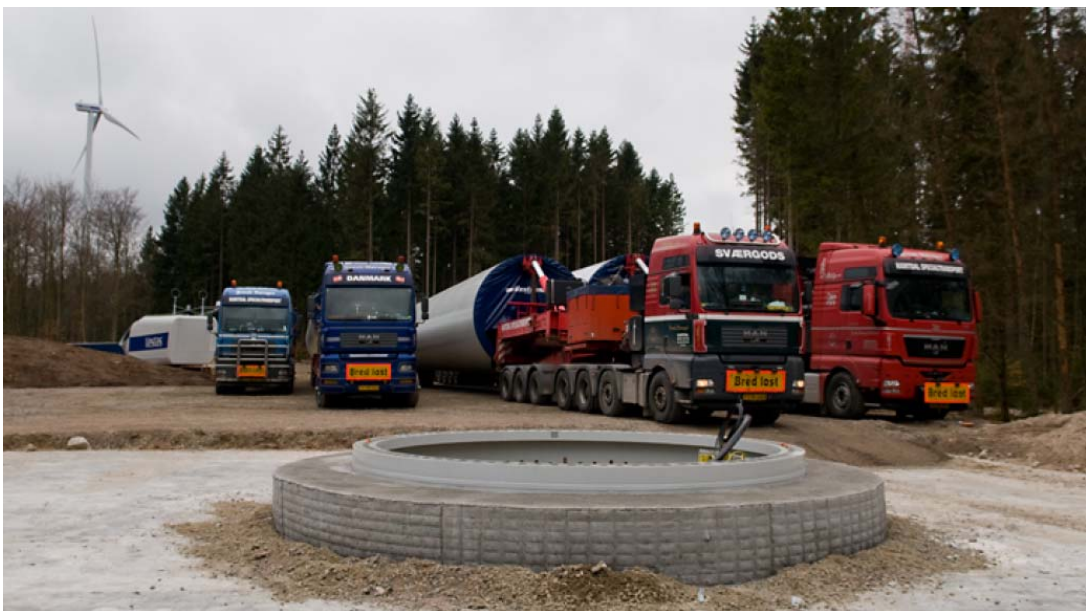
Bild 12: Fundamentet klart för montering
