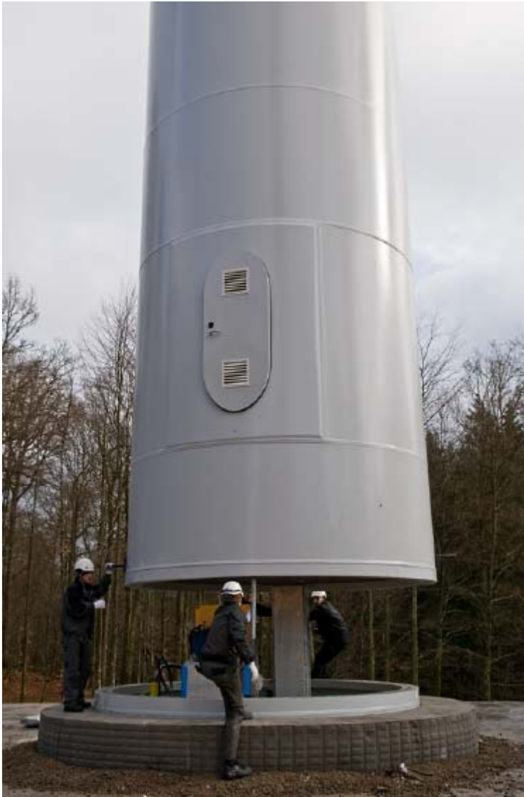
Bild 18: Montage bottendel
