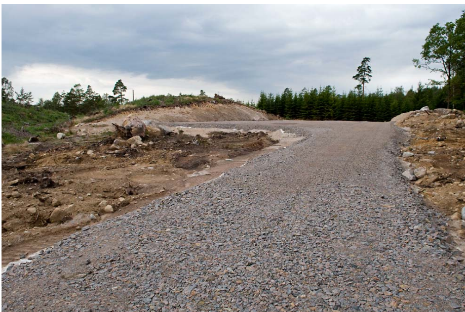
Bild 2: Ny väg & kranplats.
