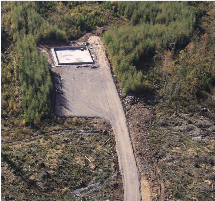
Bild 5: Fundament & kranplats från ovan. Notera vägens sträckning vilken används för montering av kranarmen (120 meter ca).
