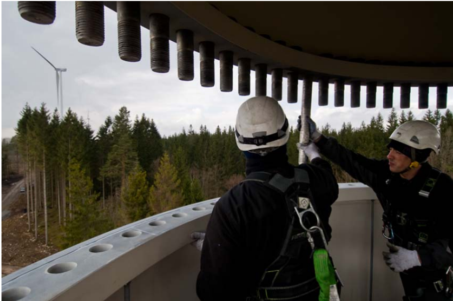
Bild 20: Inpassning torndel
